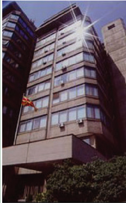
Resim 2.6. Makedonya Cumhuriyeti Merkez bankası Binası.
